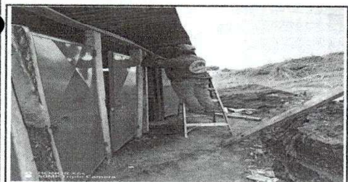
Foto 5: Colocación de puertas a sanitarios
