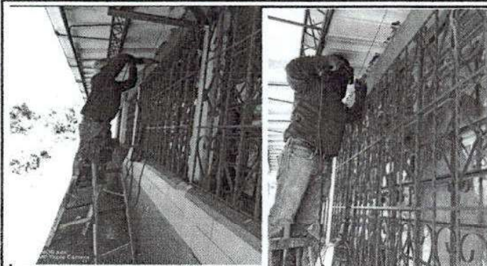
Foto1: colocación de balcones a ventanales
