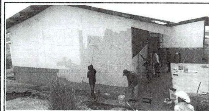
Foto 3: pintura a paredes
